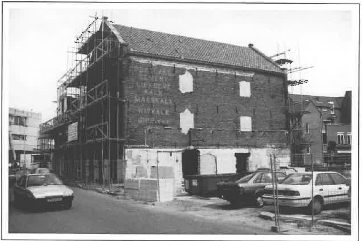
Het Hilgenpand aan de Marktstraat in de steigers. Na jarenlang verval werd het 150 jaar oude gebouw gerestaureerd. Hiermee werden mogelijkheden geschapen om er nieuwe functies in onder te brengen.
