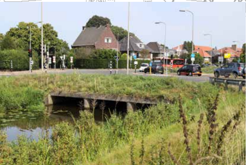
6. Na de Brugstraat leidt een dam met duiker nu over het Kanaal Almelo Nordhorn, de derde doorkruising. De Duistere Brug of Brug bij Kers lag vroeger iets meer naar het westen.
