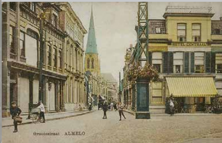
Hotel Centraal moderniseerde met een dakkapel en ontving meer gasten. Pontificaal staat nu op het pleintje een forse telegraafpaal die dagelijks water moet krijgen.
