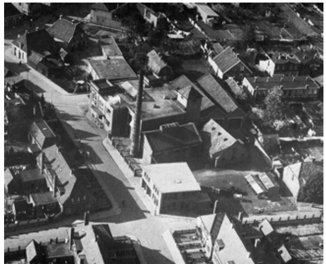
Luchtfoto fabriek hoek Melkweg/Wondestraat
