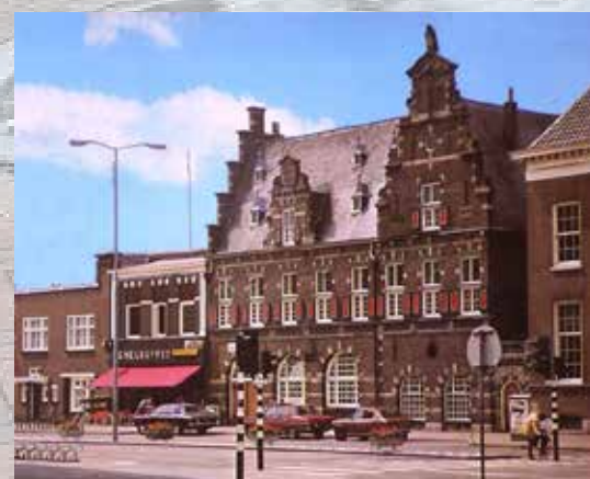
Vervolgens een snelbuffet. Links het kantoorgebouw van het Huis van Bewaring.
