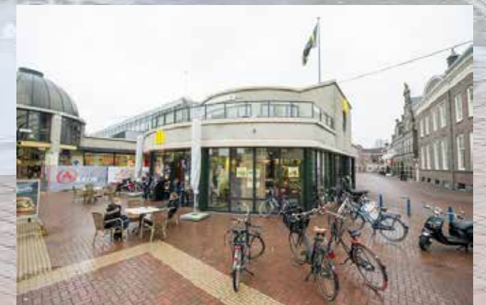
De vierbaansweg werd een passage met winkels en McDonald's een sta in de weg.
